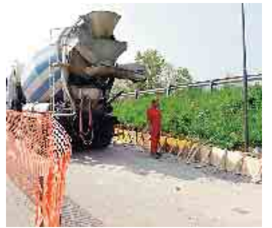
RIVERGARO - Cominciati i lavori in piazza Dante per la nuova isola ecologica: il cantiere proseguirà fino al 25 aprile (foto Zangrandi)
